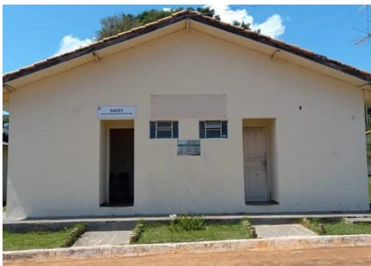
Figura 1. Vista de frente do local onde o SAEst está alocado no Campus de Pontes e Lacerda
